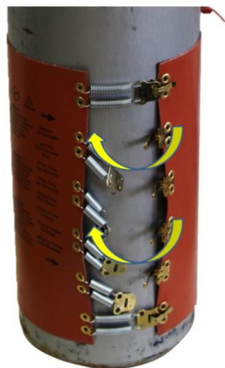
Figura 8: Fixe todos os retentores da mola tensora
